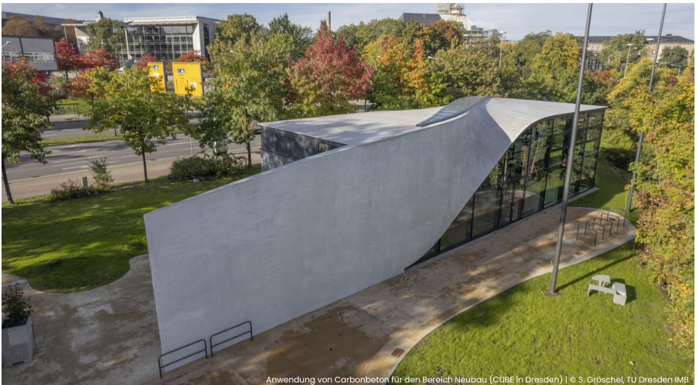
Anwendung von Carbonbeton für den Bereich Neubau (CUBE in Dresden) | © S. Gröschel, TU Dresden IMB
